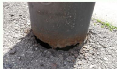
写真1 腐食した街路灯ポールの根元(高崎市HPより)
