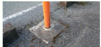
写真2 コンクリートで固定したポール
